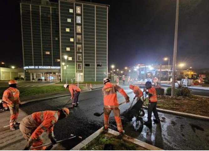
Jusqu'à 1000 tonnes d'enrobé par nuit ont été posées par l'entreprise Colas qui a réalisé ces travaux. © Francis Pivet for Groupe ADP.
