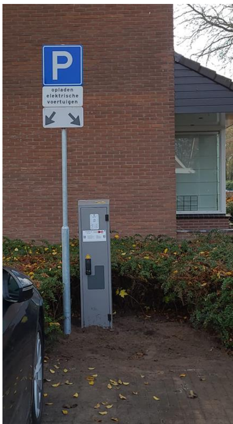
Figuur 7 Plaatsing laadpaal onverharde grond, zonder tegelplateau.
