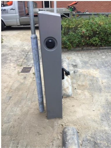
Figuur 3 Tussen de varkensruggen geplaatste laadpaal heeft geen enkele aanrijdbescherming.
